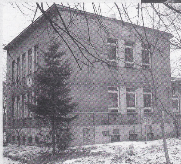
Dużo trzeba będzie w ten budynek zainwestować
